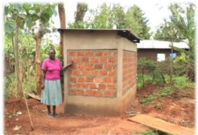
Julia zeigt stolz das neue WC-Häuschen mit Durchabteil
